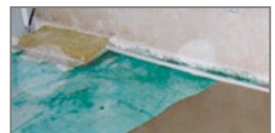
Application of primer
